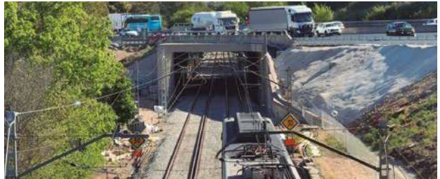
Fotografía de diario digital, zona de accidente con trabajos terminados.
