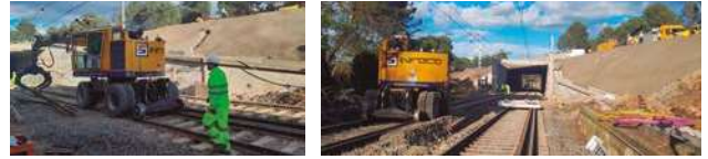
Fotografías de Autor, de trabajos ferroviarios la tarde del sábado día 7 de febrero.
