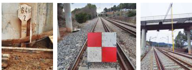
Fotografías de Autor de la afección al sistema ferroviario en relación a la Seguridad.
