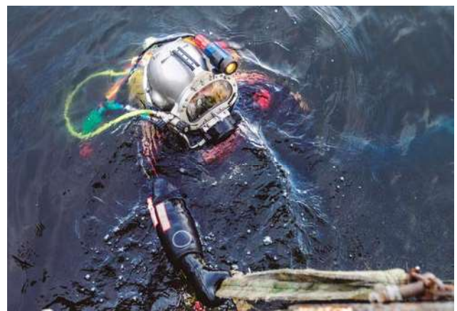
Reparació de l'emissari submarí de l'EDAR Mataró.
