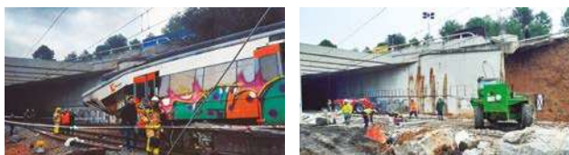
Fotografía del diario digital de la zona de impacto del tren contra el muro de hormigón. Foto del autor para comparativa.
