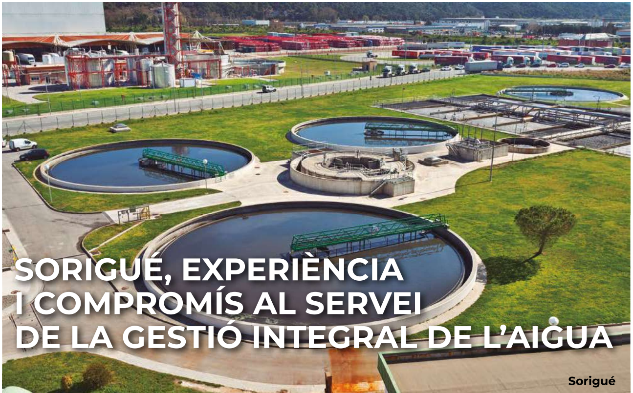
Gestió integral de residus generats a l'EDAR de Montornès del Vallès.
