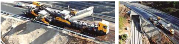
Equipos de trabajo de extendido de Mezclas Asfálticas la mañana del domingo día 8.
