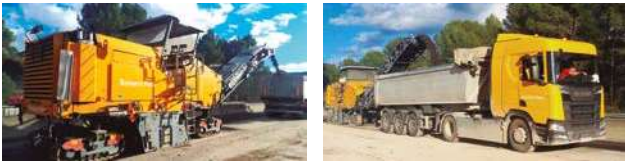
Equipos de ROMERO POLO SAU en fase de fresado y preparación de explanada el sábado día 7 para preparar el extendido de Mezclas Asfálticas del domingo día 8.
