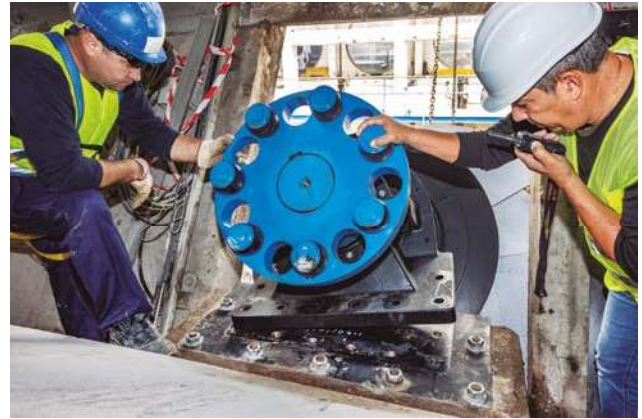
Reposició cargols d'Arquimedes EBAR Sant Adrià del Besòs.
